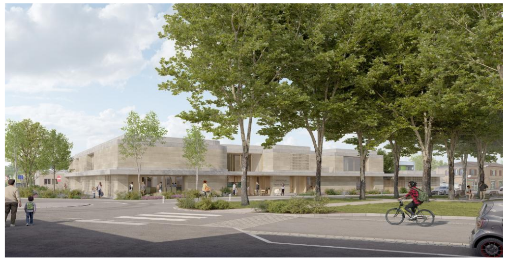
Vue extérieur – Crédit : OS Architecture
