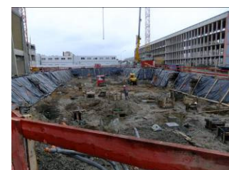
Photographies du chantier
