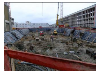
Photographies du chantier
