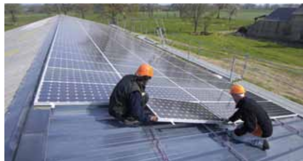
Pose de panneaux photovoltaïques sur un bâtiment agricole.
