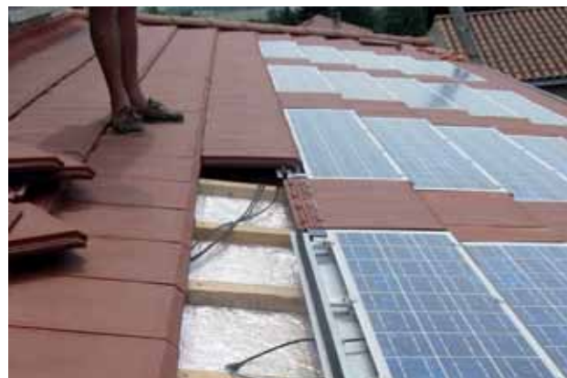
Intégration en toiture de tuiles photovoltaïques.
