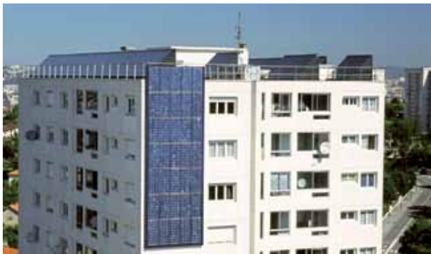
Cet immeuble de l'OPH du Grand Lyon est doté de capteurs photovoltaïques en pignon et de capteurs solaires thermiques en toiture.
