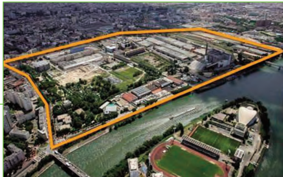
Vue aérienne (c) Vianney Prouvost / Séquano Aménagement
