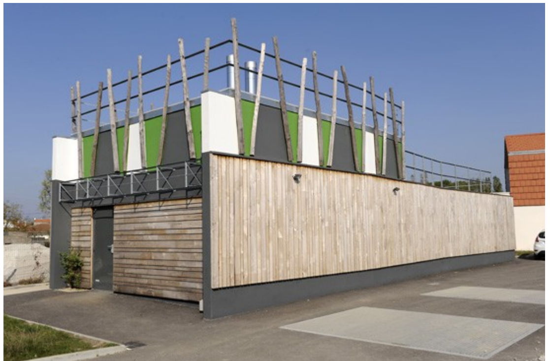
Chaufferie bois - Nantes Métropole
