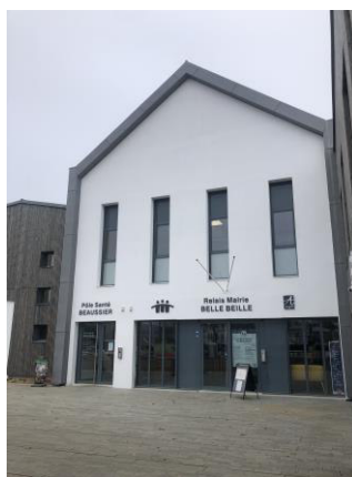
Rénovation du centre de santé Beauissier
