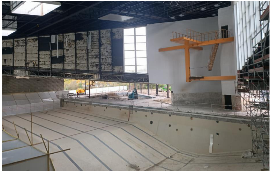
Halle bassins en cours de curage
