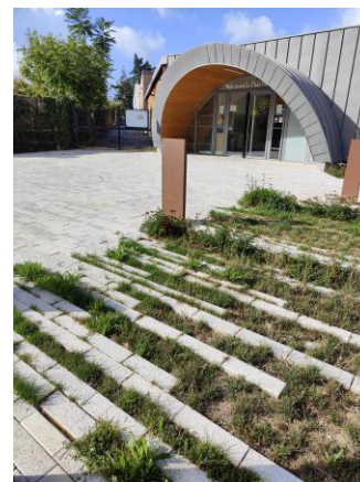
Revêtement semi-perméable espace public
