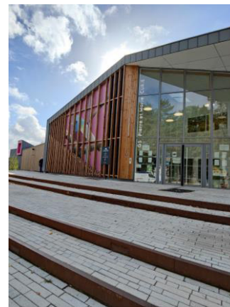
Rénovation du groupe scolaire PMI
